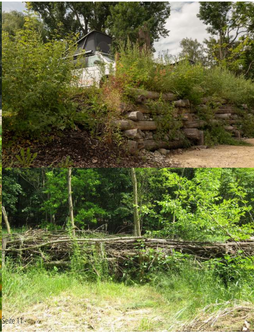
oben: Krainerwand auf Naturcampingplatz Mainau-Litzelstetten, unten: Benjeshecke
